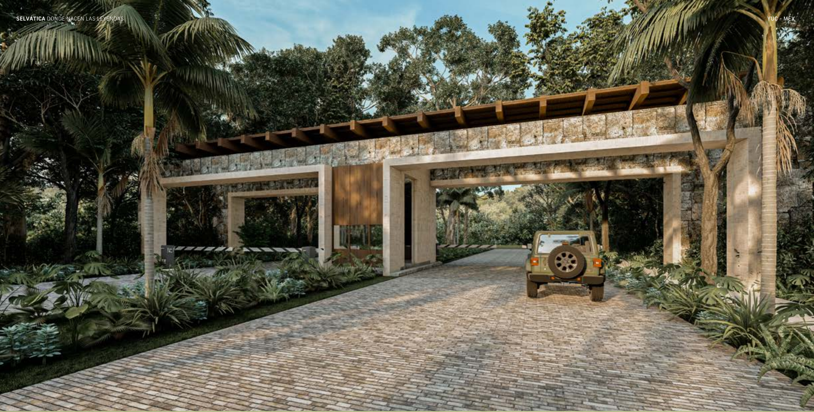
PÓRTICO DE ACCESO A ETAPA 1
